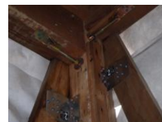
耐震補強工事
