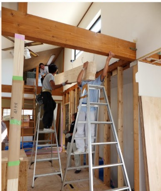
4メートルを超える梁を設置中
