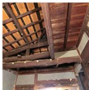
玄関天井 解体中
