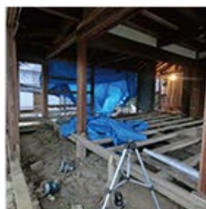
和室床 解体中
